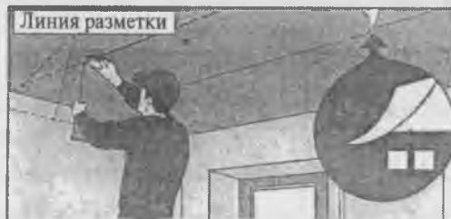
Приклеивание второго полотнища
