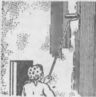
Рис. 40. Окраска силикатной краской с помощью валика
