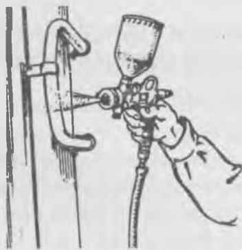
Рис. 42. Окраска стен вододисперсионной синтетической краской с помощью краскораспылителя
