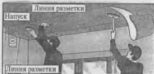
Приклеивание первого полотнища
