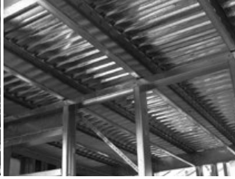
Рис. 9.9. Общий вид междуэтажного перекрытия из профлиста
