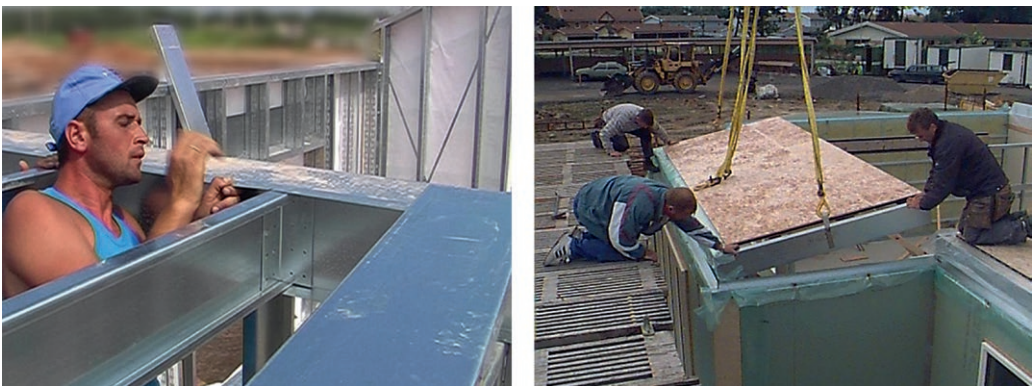
Рис. 9.14. Монтаж балок перекрытия поэлементно (фото слева) и панелями (справа)
