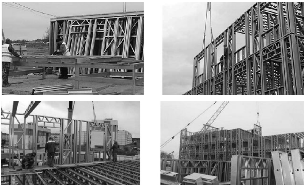
Рис. 5.6. Изготовление и монтаж каркасов стен и перекрытий 4-этажного многоподъездного многоквартирного здания по ярусной системе из каркасов с соединениями типа С + С
