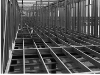
Рис. 9.8. Общий вид цокольного перекрытия по металлическому свайному
