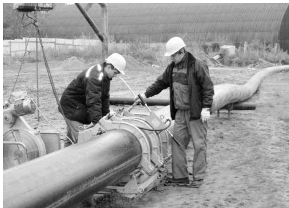
Фото 4.2.1 Стыковая сварка ПЭ труб в полевых условиях
