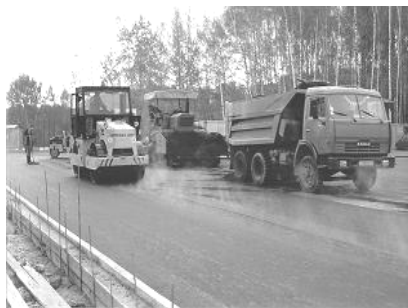
Рис. 4.1. Укладка асфальтобетонной смеси одним асфальтоукладчиком со смещением полос дорожного покрытия
