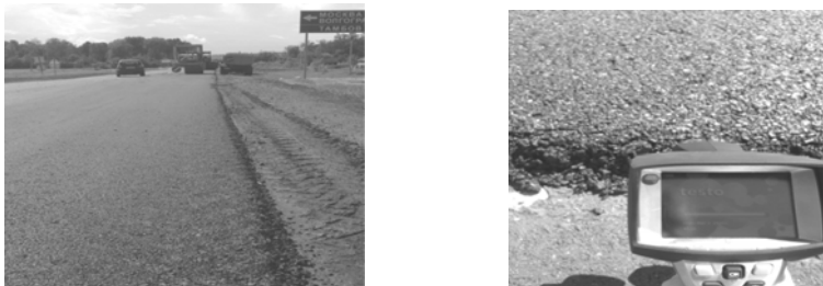
Рис. 2.15. Съёмка тепловизионной камерой распределения температуры при устройстве асфальтобетонного покрытия
