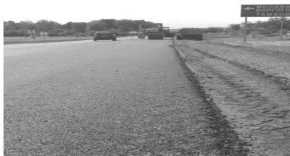
Рис. 3.8. Строительство асфальтобетонного покрытия на участке автомобильной дороги «Тамбов–Воронеж»
