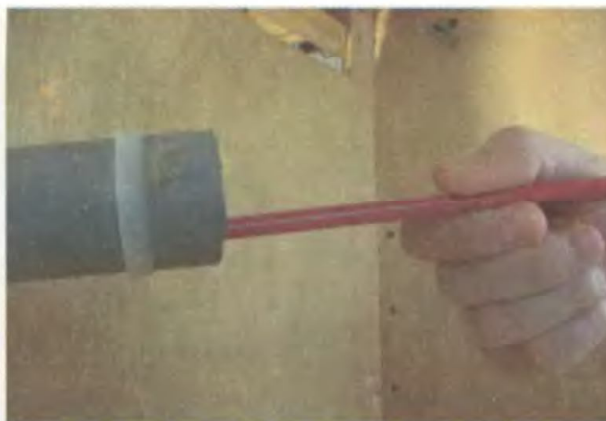
5. Протолкните его внутрь до соприкосновения с пробкой
