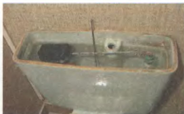
5. Уровень воды в заполненном смывном бачке не должен доходить до отверстия сливной трубы
