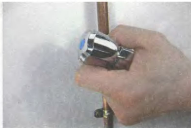
4. Ввинчивайте кран до тех пор, пока он не прорежет медную трубу
