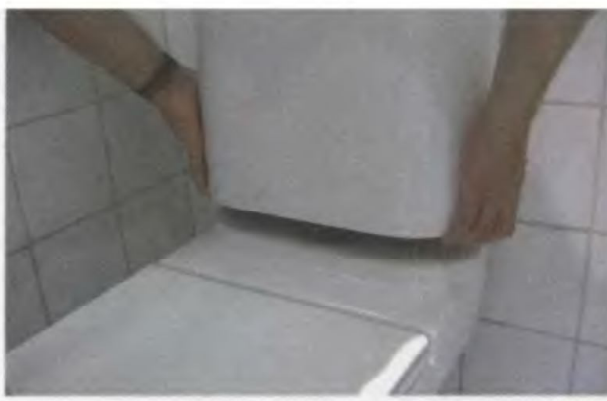
11. Поместите смывной бачок на унитаз, закрепите его винтами и подсоедините к бачку шланг подачи воды
