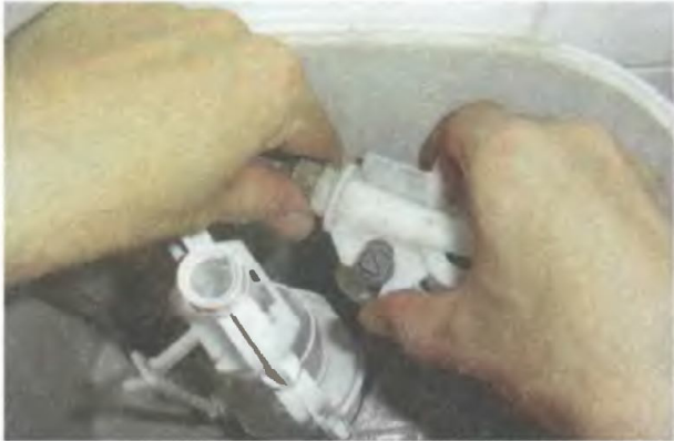
1. Отвинтите кран-поплавок от стенки бачка
