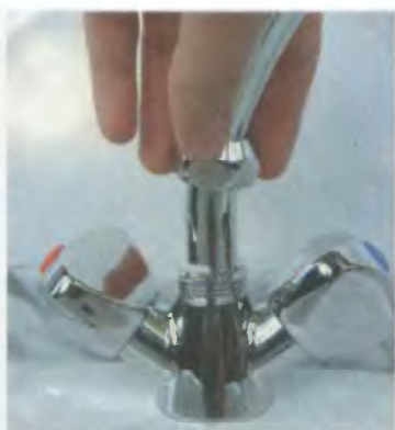
1. В случае протечки отвинтите гайку раковины и снимите горловину смесителя
