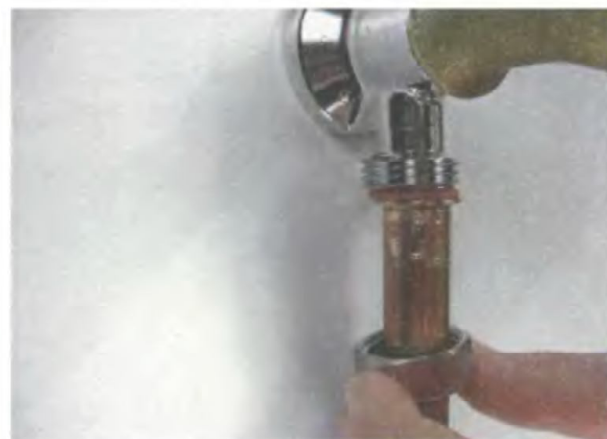
2. Отвинтите гайку и извлеките из-под нее прокладку
