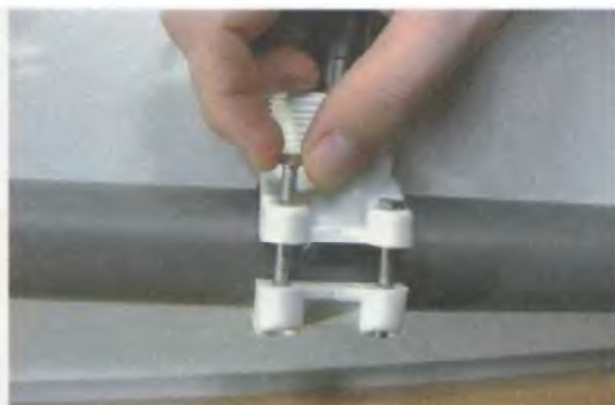
4. Закрепите хомут на канализационной трубе
