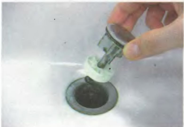
2. Извлеките клапан старого слива
