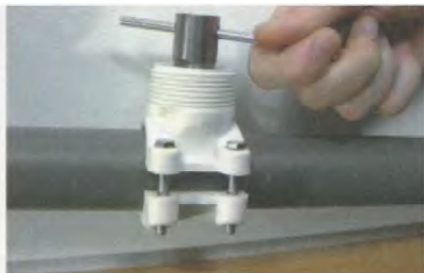
5. Просверлите трубу с помощью воротка со сверлом
