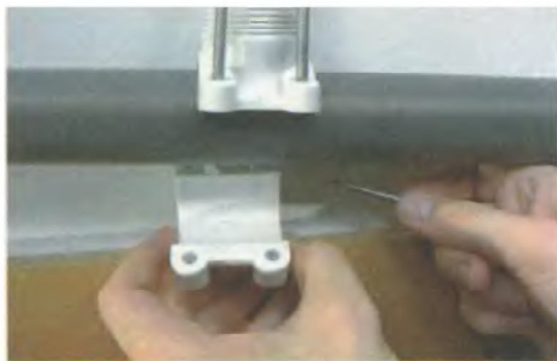
3. Установите хомут по месту на трубе
