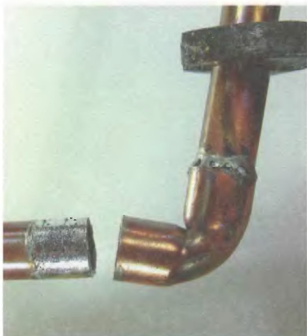
2. Когда припой расплавится, отделите куски трубы друг от друга, используя плоскогубцы
