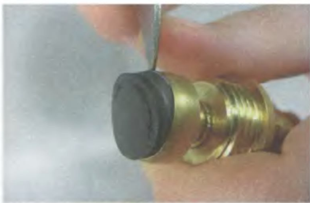
3. Выньте прокладку из латунного гнезда, используя нож или другой острый предмет
