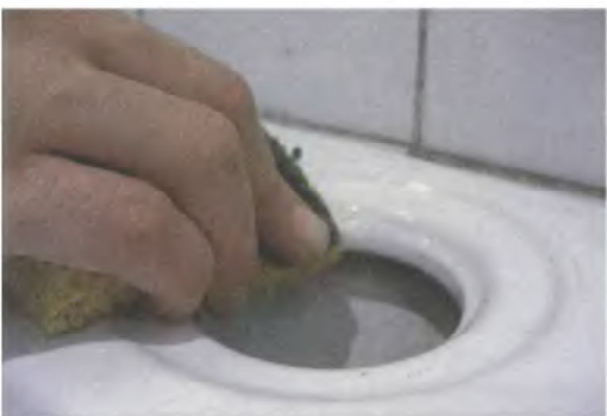
9. Тщательно очистите место под прокладку
