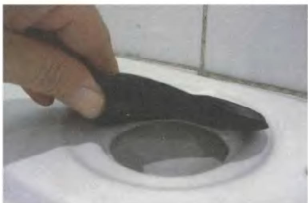
8. Извлеките уплотнительную прокладку, установленную между смывным бачком и унитазом
