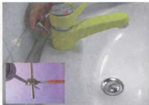
12. Уравновесьте металлические тяги и установите хомут, а затем проверьте работу слива
