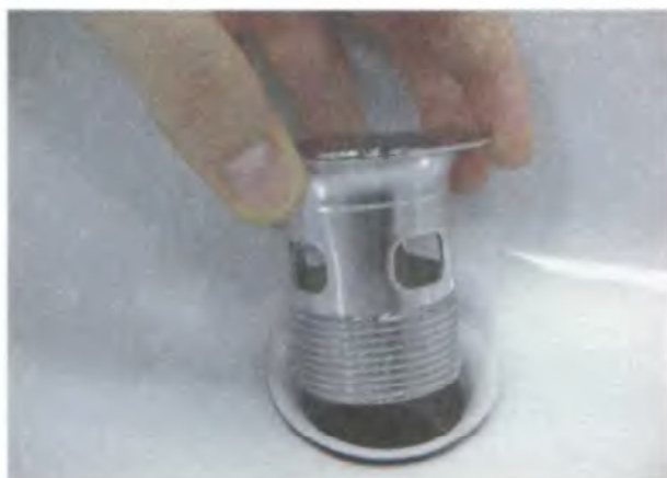
9. Установите верхнюю часть слива в отверстие
