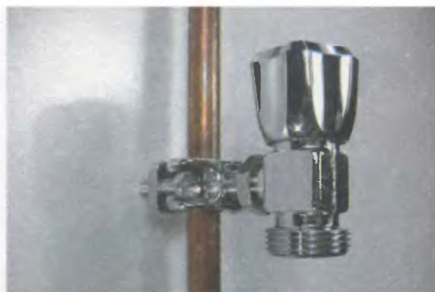
6. После установки на трубу кран больше нельзя отсоединять
