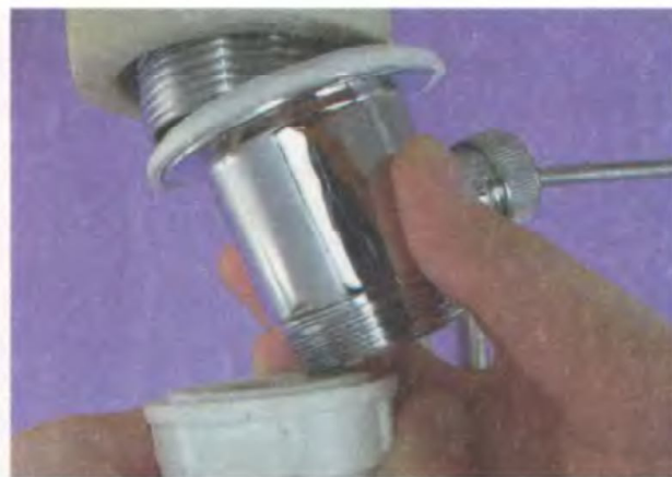
10. Установите герметичное соединение, а затем привинтите нижнюю часть, тягой назад
