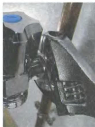
4. Ввинчивайте кран до тех пор, пока он не прорежет медную трубу
