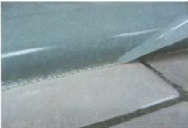
3. Нанесите на стык тонкий слой герметика
