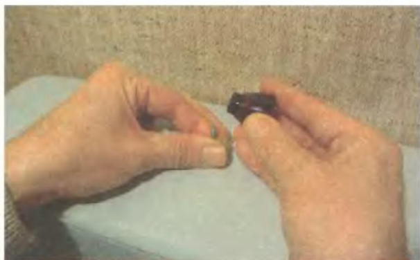
1. Отсоедините спусковой рычаг и снимите крышку бачка
