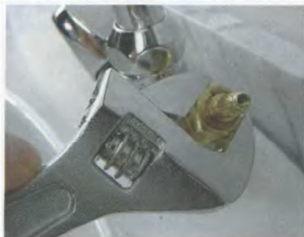
2. Жестко зафиксируйте буксу в корпусе крана
