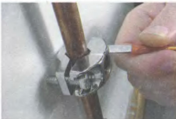
2. Установите хомут на трубу с холодной водой
