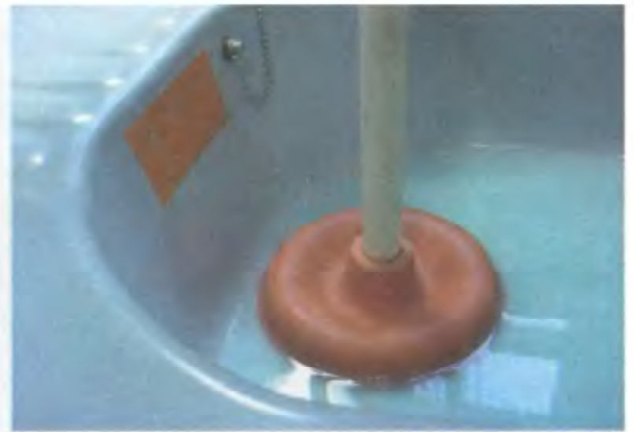
5. Прижмите вантуз к сливному отверстию раковины
