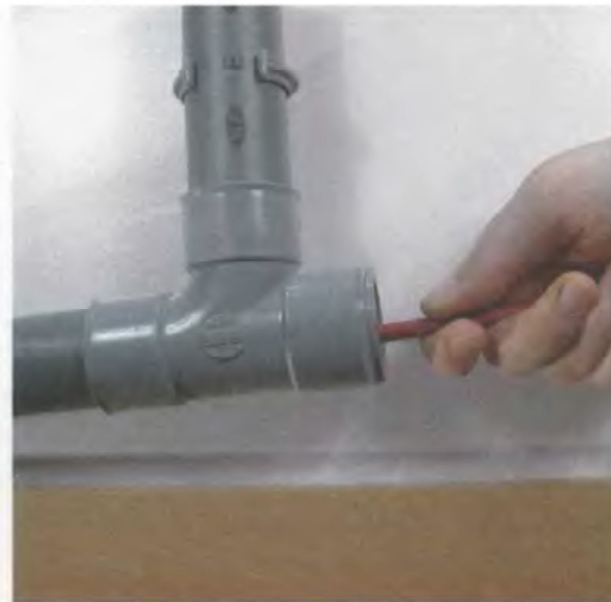
3. Проталкивайте трос внутрь до тех пор, пока он не упрется в засор или изгиб трубы
