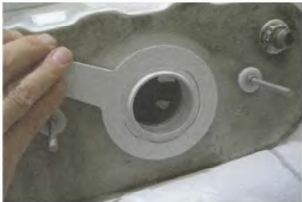
7. Закрепите новую подставку сливного механизма
