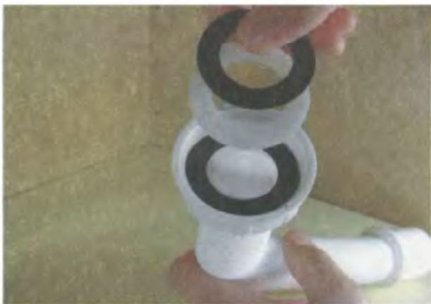
2. Уложите прокладки и уплотнительные кольца внутрь пластмассовой гайки
