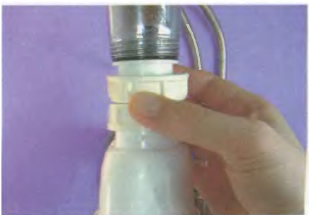
3. Отвинтите верхнюю гайку сифона
