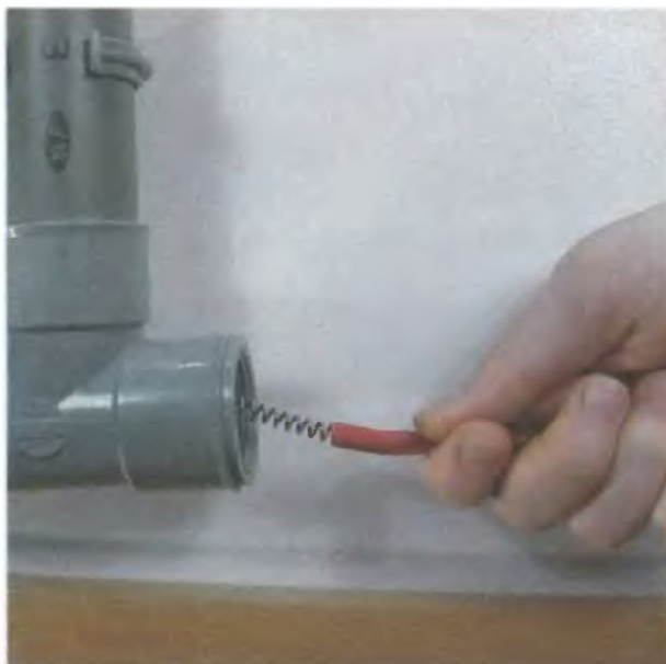
2. Введите наконечник металлического троса в трубу
