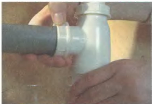
2. Отвинтите гайку, соединяющую сифон со сливной трубой
