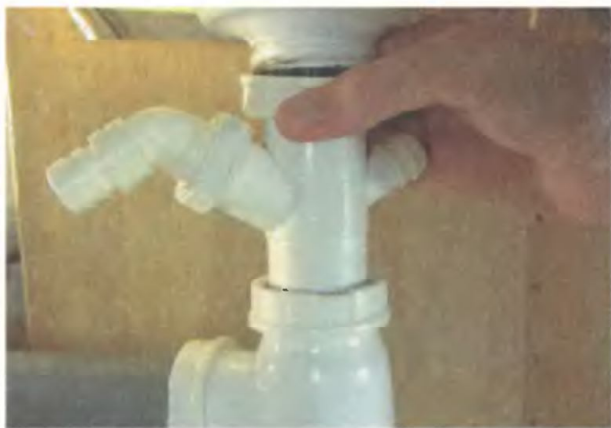
1. Отвинтите сифон от сливного отверстия
