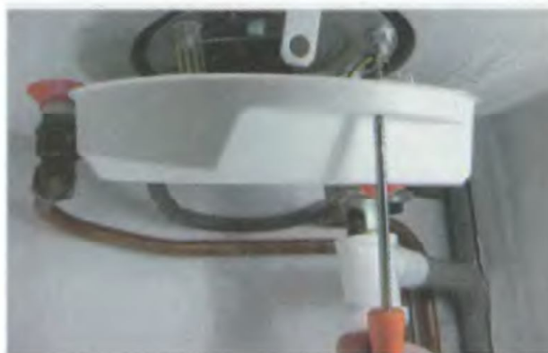
2. Снимите защитную крышку бака
