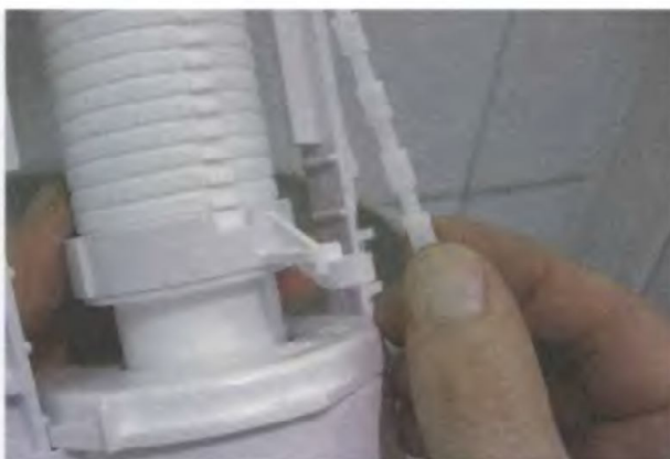
12. Отрегулируйте поплавок и установите его в бачок
