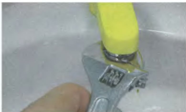
1. Отвинтите регулятор струи с помощью разводного гаечного ключа
