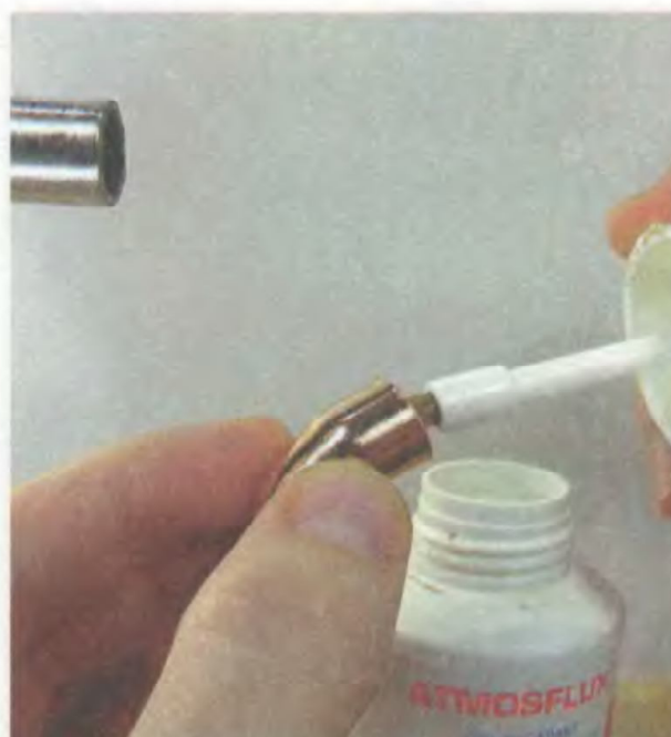
4. Возьмите новый угловой фитинг. Смажьте флюсом внутреннюю поверхность фитинга и внешнюю поверхность трубы
