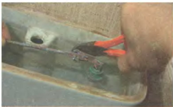
3. Затяните регулировочную гайку
