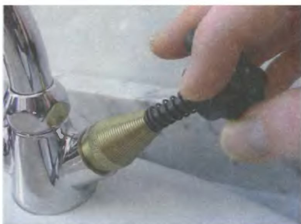
3. Поверните рукоятку притира два-три раза
