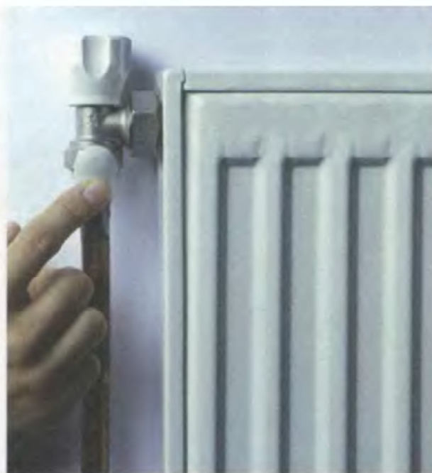
Для соединения разных материалов (железо, медь, латунь) используйте универсальную мастику
