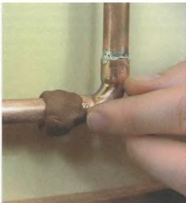
5. Нанесите мастику на место протечки и разгладьте ее
