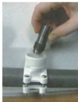
5. Просверлите трубу с помощью воротка со сверлом
