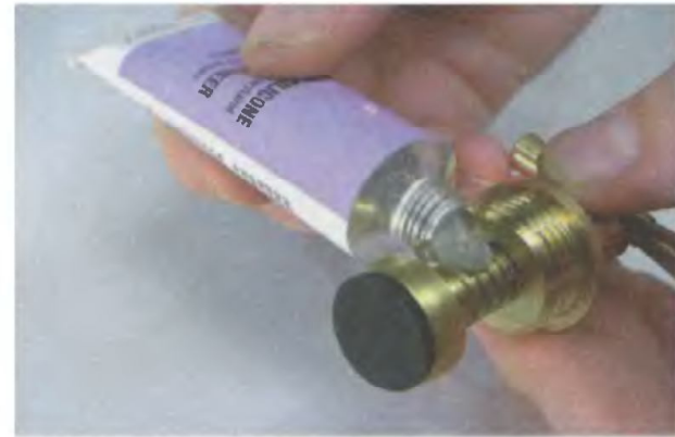
6. Перед сборкой крана нанесите на тягу и клапан специальную смазку или силикон
