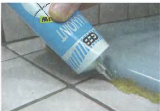
3. Обильно смочите растворителем остатки герметика
