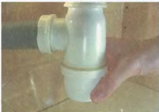
2. Отвинтите дно сифона и подождите, пока стечет вода
