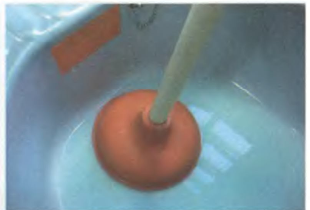
6. Прокачивайте воздух вантузом до тех пор, пока стоящая в раковине вода не уйдет в сливное отверстие
