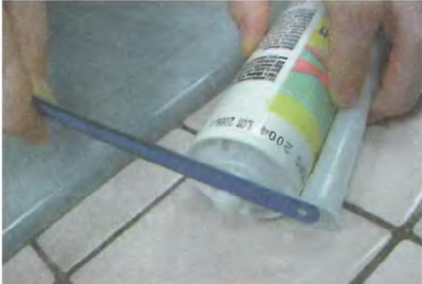
1. Отрежьте кончик патрона с герметиком
