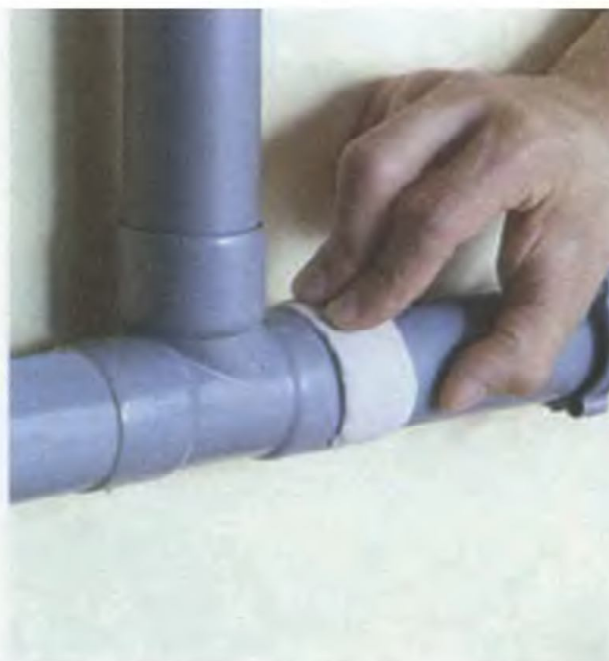
Для труб, изготовленных из ПВХ, существуют специальные эпоксидные мастики
