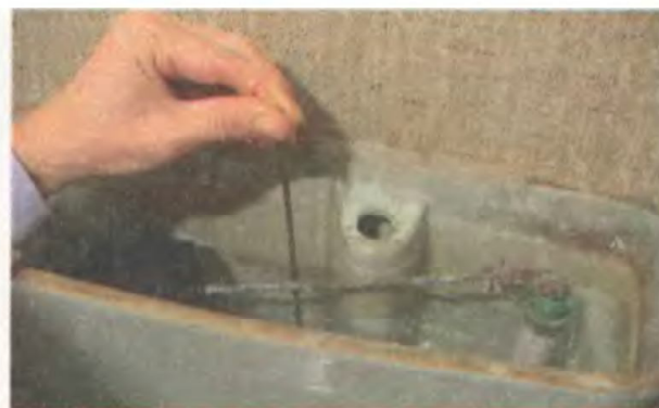
4. Проверьте работу смывного бачка, потянув за спуск
