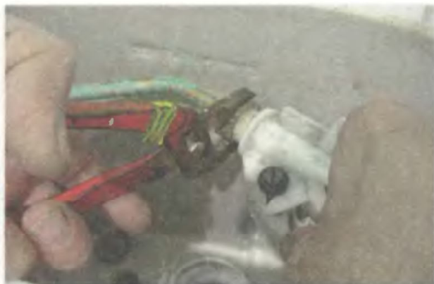
6. Установите на место кран-поплавок
