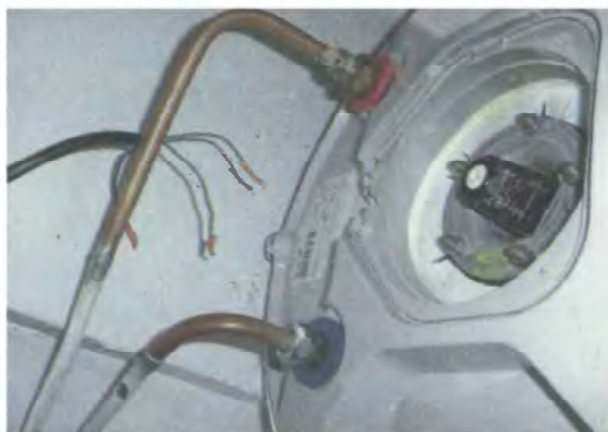
2. Отключите электрический ток и отсоедините провода
