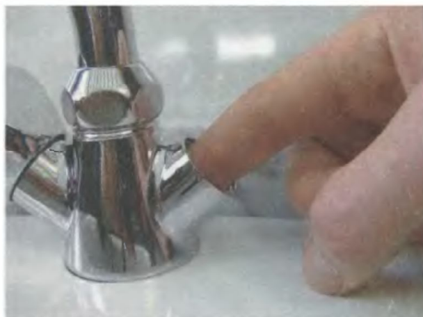
1. Проверьте пальцем состояние поверхности седла
