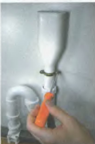
9. Прикрепите воронку сифона к стене с помощью имеющегося в наборе хомута
