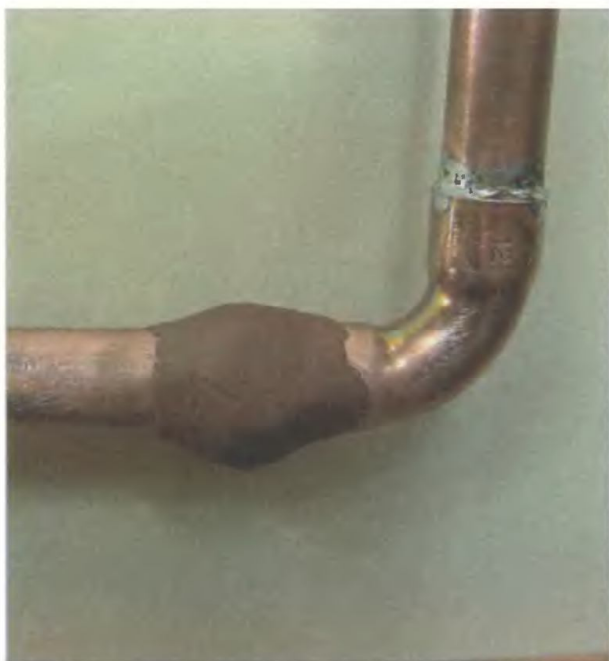
6. Мастика полностью затвердеет через 3 часа. Затем ее можно отшлифовать и покрасить
