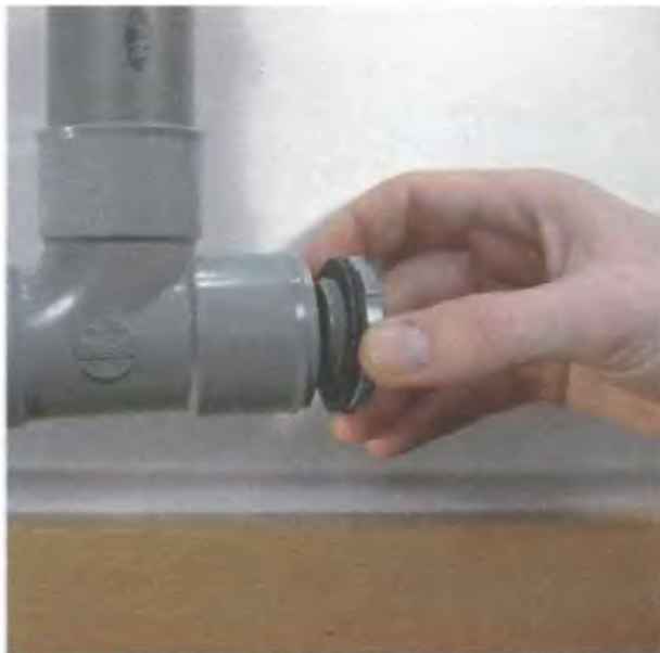
1. Отвинтите заглушку отверстия для чистки. Будьте осторожны – из отверстия может хлынуть вода
