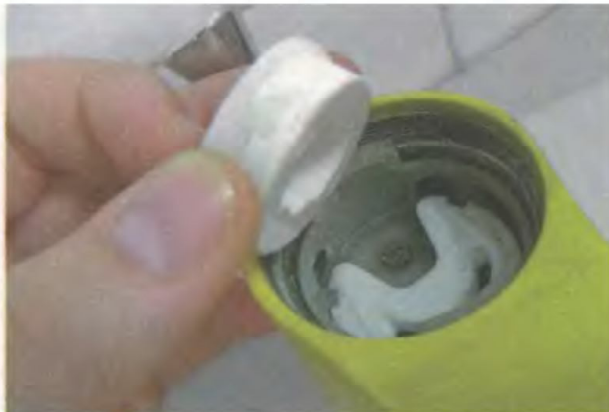
4. Извлеките наружу изношенные диски (показаны на рисунке) или патрон с керамическими дисками
