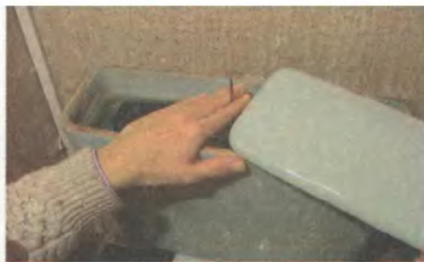
6. Установите на место крышку и спусковой рычаг
