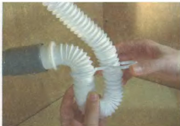
5. Приклейте гибкий шланг к муфте и наденьте на него фиксатор, чтобы шланг сохранял форму
