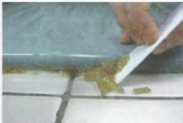
5. Соскоблите остатки размягченного герметика
