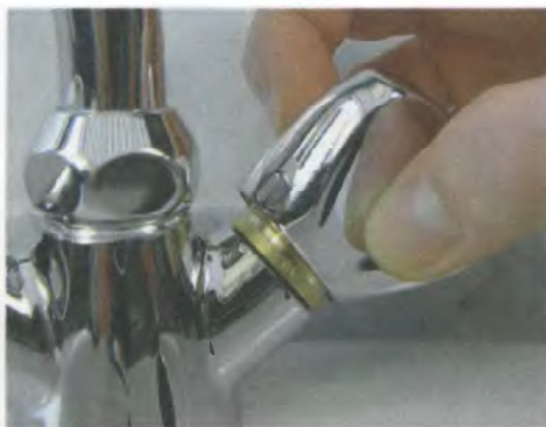
3. Установите на место головку крана
