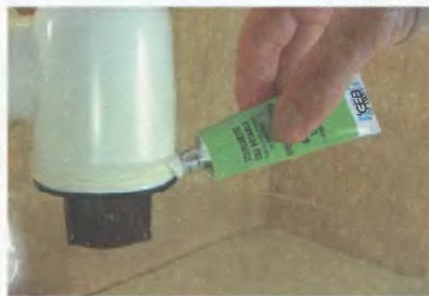
4. Для герметизации дна сифона нанесите на резьбу мастику
