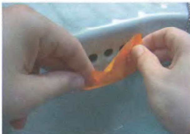
3. Заклейте им отверстия в верхней части раковины
