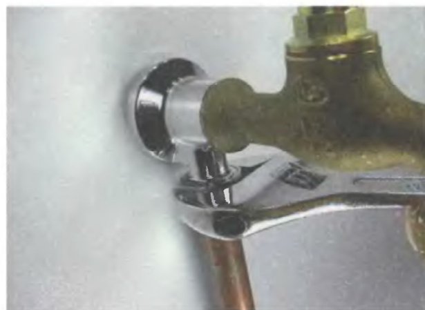
1. Перекройте воду, а затем ослабьте гайку
