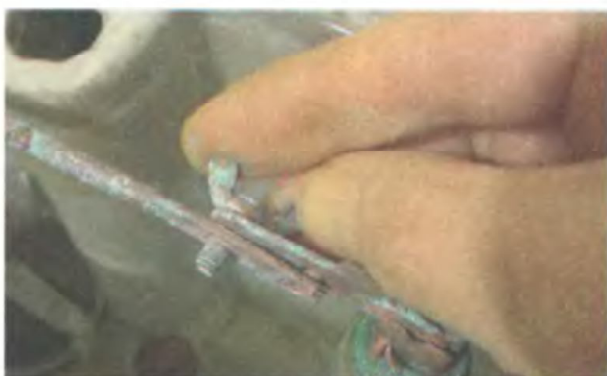
2. Отрегулируйте стержень крана-поплавка
