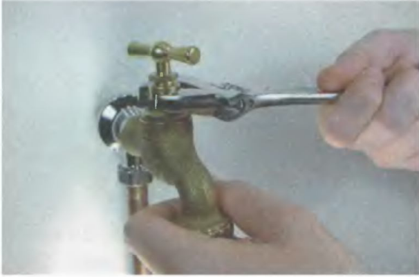
1. Перекройте воду у счетчика, затем открутите кран с помощью разводного гаечного ключа
