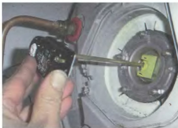
8. Затяните гайки и установите термостат
