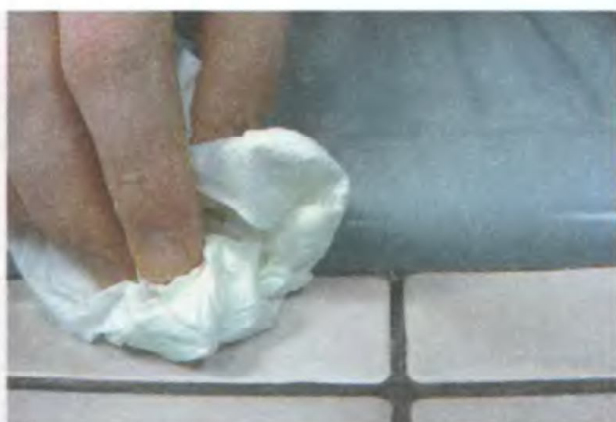
6. Промойте место соединения водой и протрите сухой тряпкой
