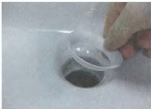
8. Положите в отверстие новую прокладку или промажьте отверстие по периметру мастикой
