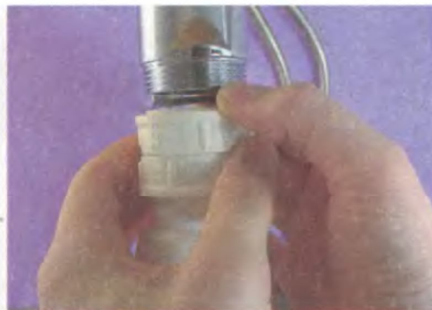
11. Совместите сифон со сливом и закрутите пластмассовую гайку
