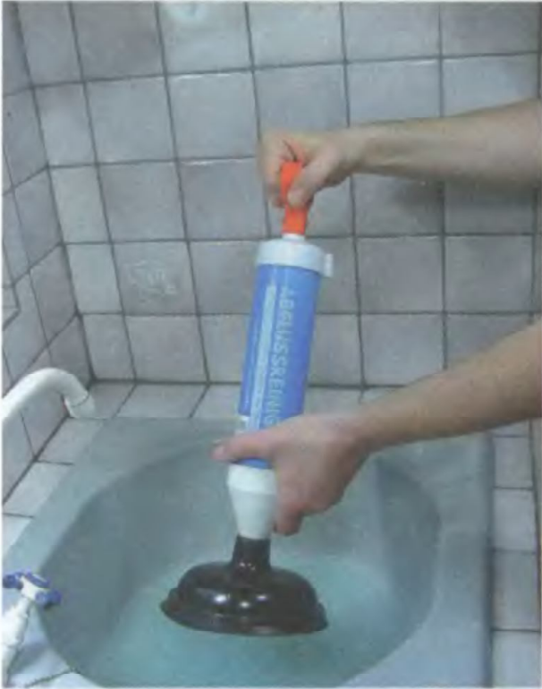
1. Заклеив отверстия в верхней части раковины широкой клейкой лентой, возьмите вантуз с насосом
