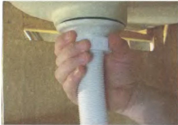
3. Затяните гайку гибкого шланга на сливе
