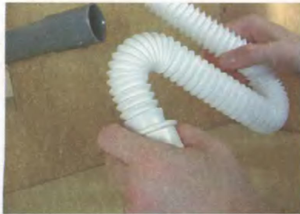
4. Приклейте муфту к сливной трубе и придайте гибкому шлангу форму сифона
