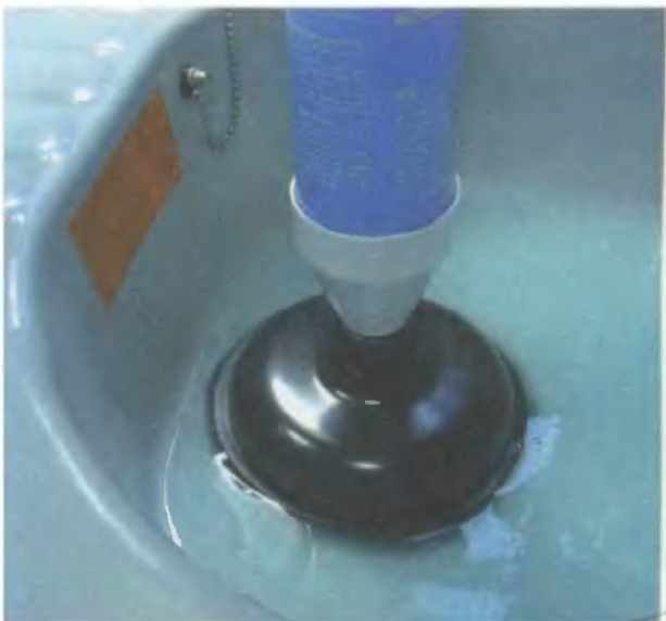
2. Прижмите вантуз к решетке сливного отверстия
