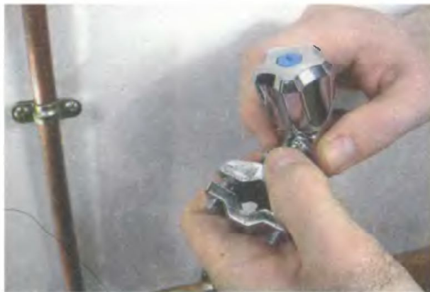
1. Отсоедините хомут самонавинчивающегося крана
