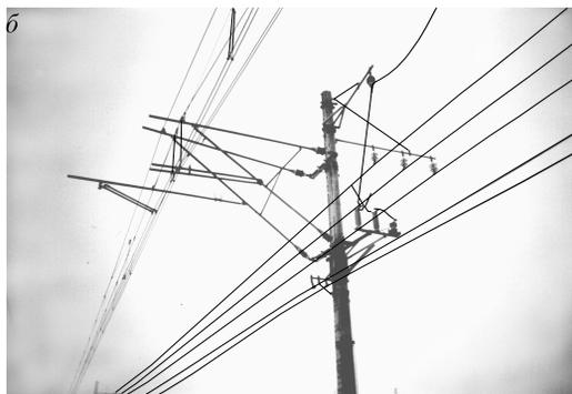
Рис. 9.15. Ограничитель перенапряжения постоянного тока (а); установка ОПН на опоре (б): 1 — кронштейн; 2 — балка разрядника; 3 — планка опорная; 4, 5 — дугогасящие рога; 6 — ОПН; 7 — изолятор; 8, 9, 10 — зажимы соединительный, струновой, заземляющий; 11 — болт крюковой; 12 — проволока  $\varnothing 1,4$  мм; 13 — провод М-70 или ПБСМ-70
