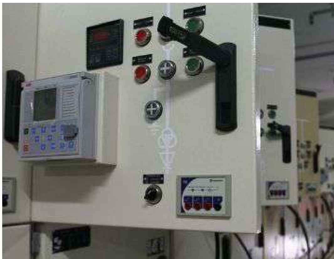
Рисунок 5.3.1.3 Ревизия высоковольтной ячейки
