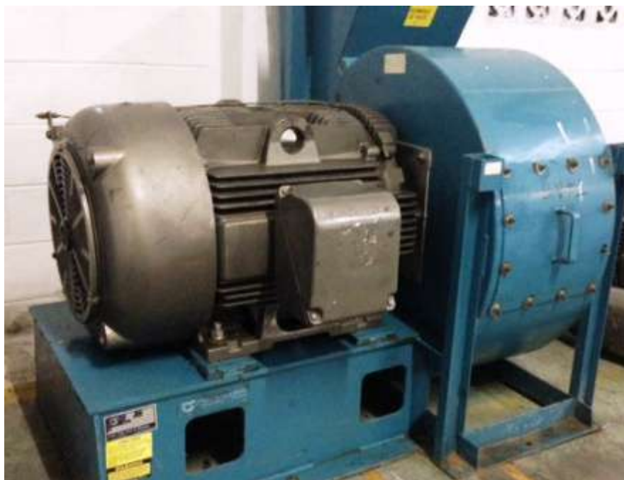
Рисунок 5.1.1.1 Электродвигатель с вентилятором
