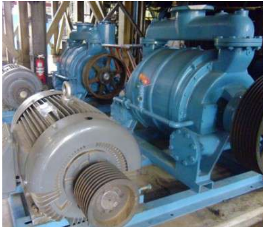
Рисунок 5.1.1.3 Выполнение соосности двигателя с механизмом
