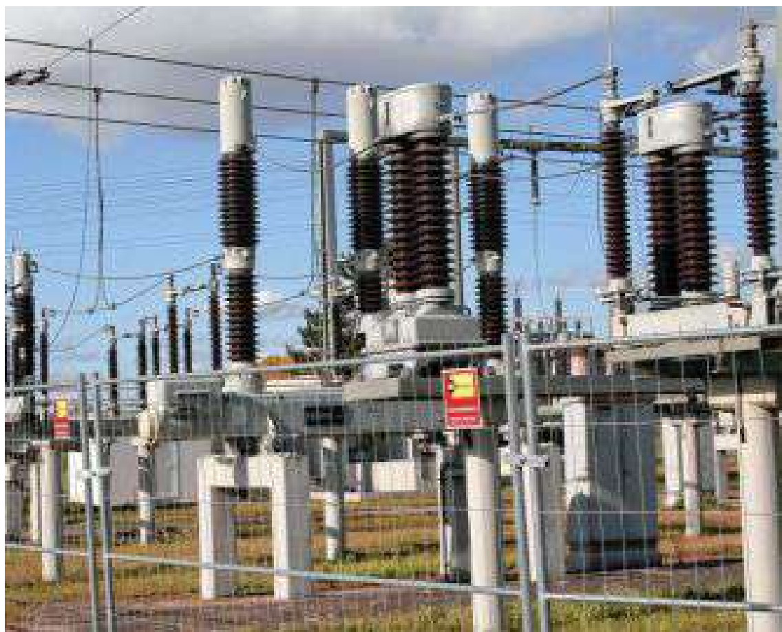
Рисунок 5.3.1.1 Трансформаторы тока
