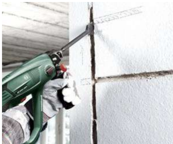
Рисунок 2.2.4.4 Производство дополнительных штроб для прокладки провода.
