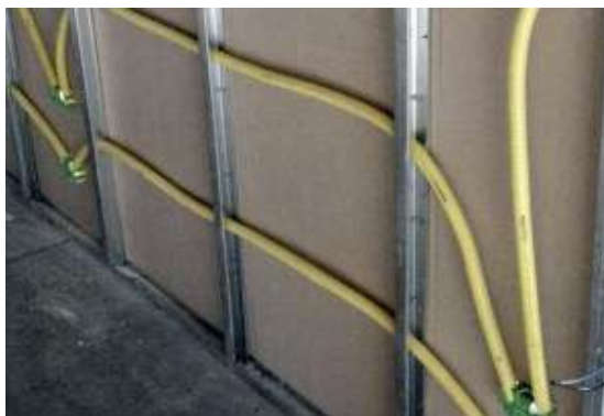
Рисунок 2.2.4.5 Прокладка проводов в перегородках.
