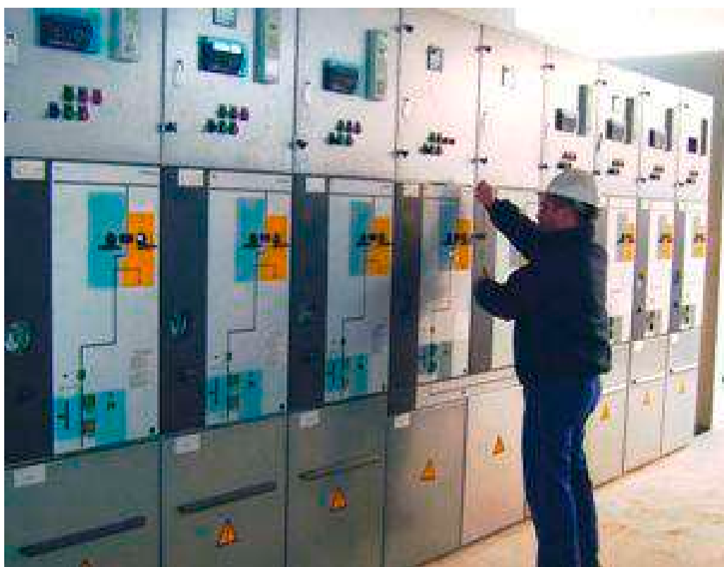
Рисунок 5.2.4.2 Распределительное устройство 6-10кВ
