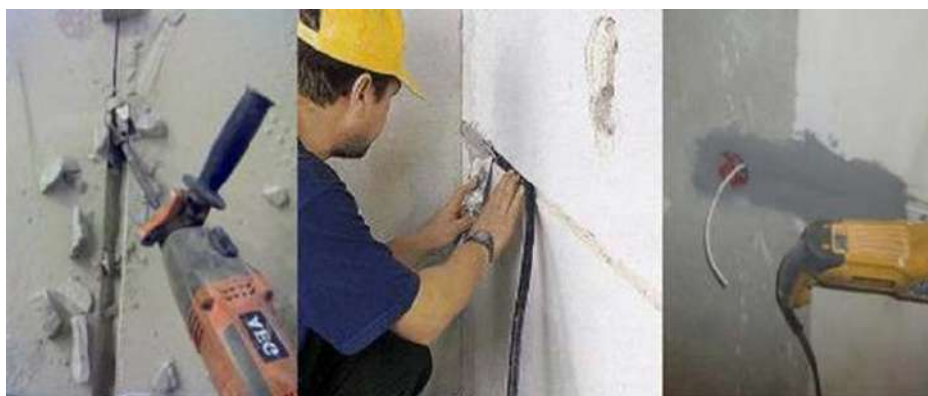
Рисунок 2.2.5.2. Один из способов прокладки кабеля проводов.
