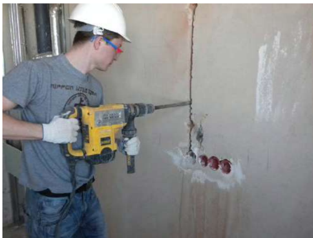
Рисунок 2.2.5.4 Использование электроинструмента для прокладки проводов.
