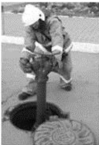
Рис. 8.20. Установка пожарной колонки
