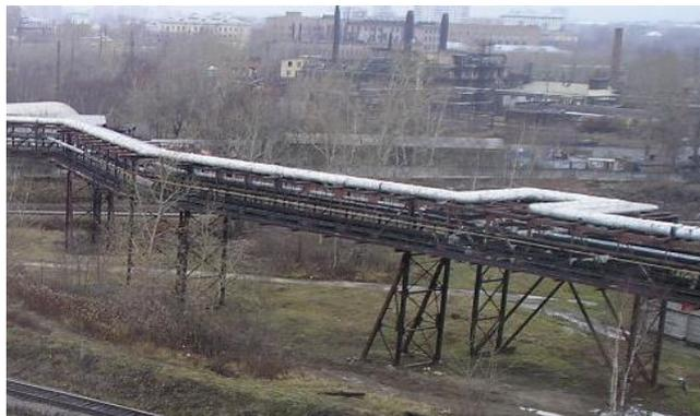
Рис. 5.6. П-образный горизонтальный компенсатор
