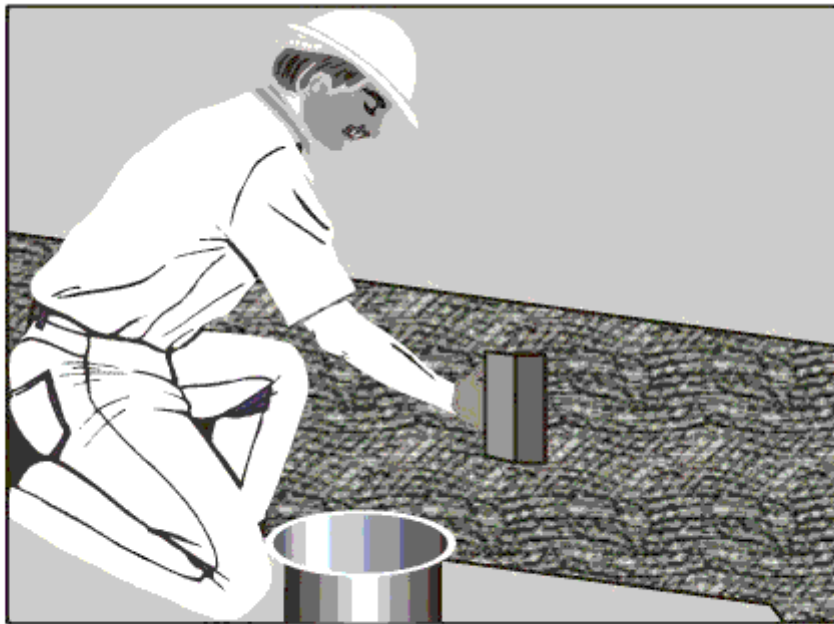
Рис. 2.2. Нанесение гидроизоляционного материала «Hidrotes-94»
