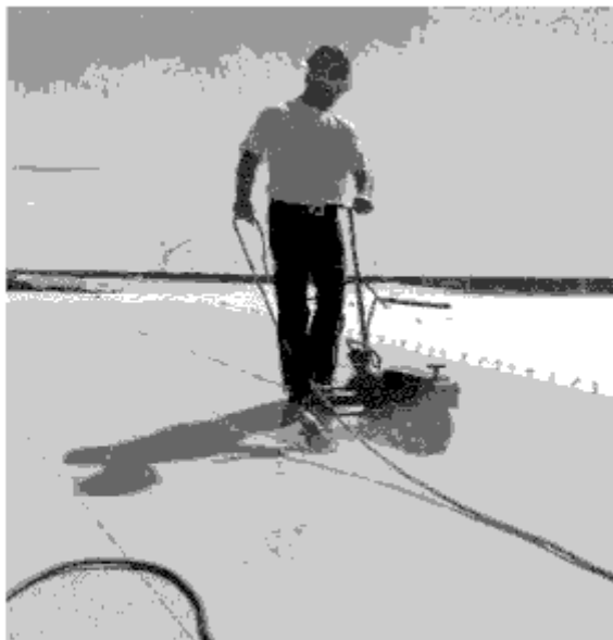
Рис. 7.3. Укладка мембраны ПЛАСТФОИЛ®(PF)
