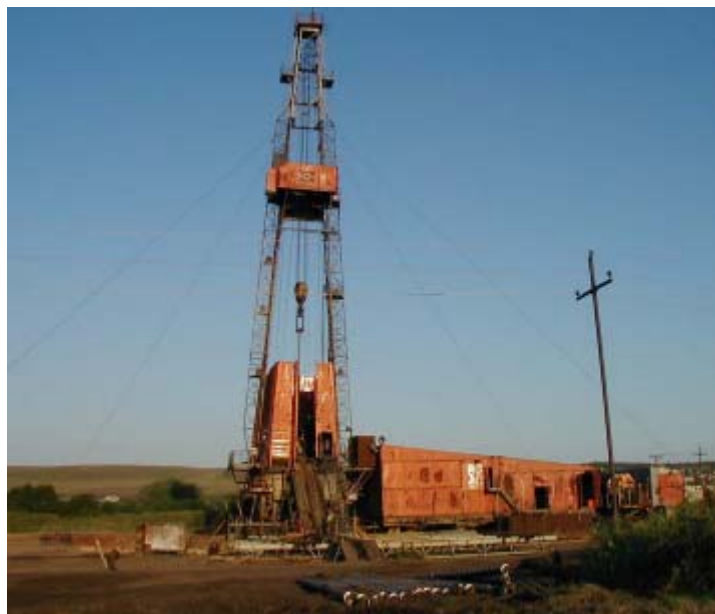
Рис. 2.11. Буровая установка, внешний вид
